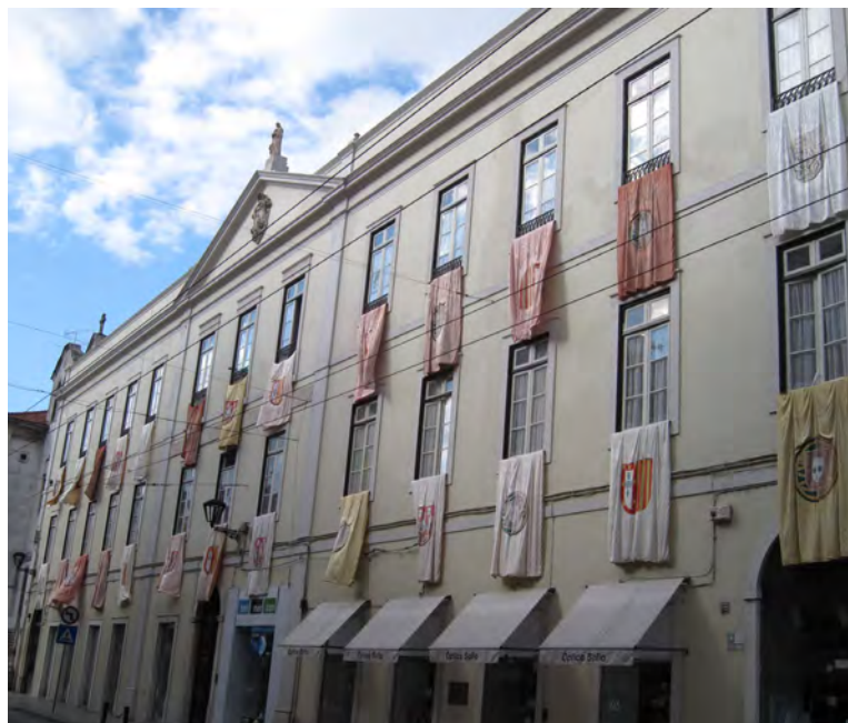
Vista da fachada principal do extinto colégio do Carmo, hoje sede da Ordem Terceira de Coimbra, sito na rua da Sofia, n.º 114, Coimbra, no dia da cidade de Coimbra, 4 de Julho de 2012.
